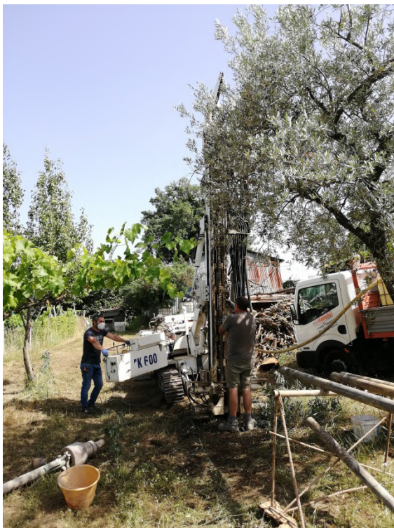
Postazione sondaggio S4
