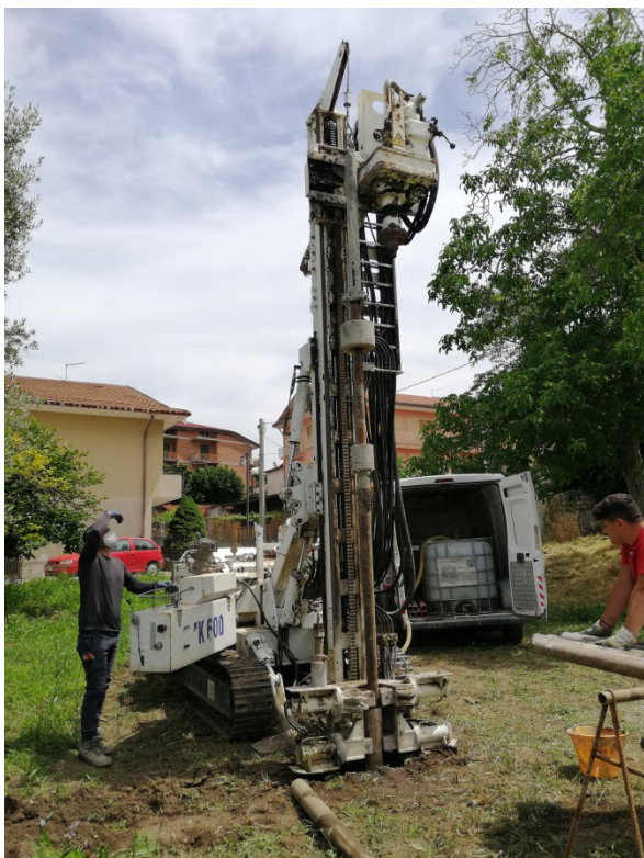
S.P.T. N.1 e N.2 eseguite nel foro S3
