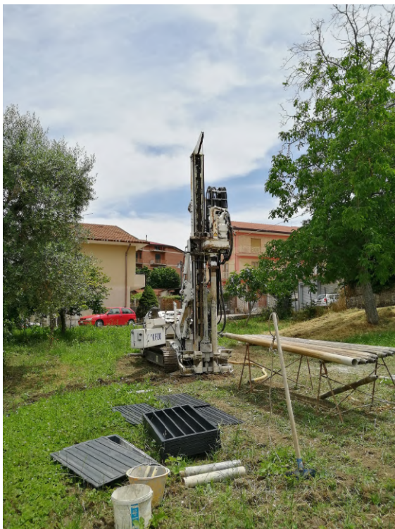
Postazione sondaggio S2
