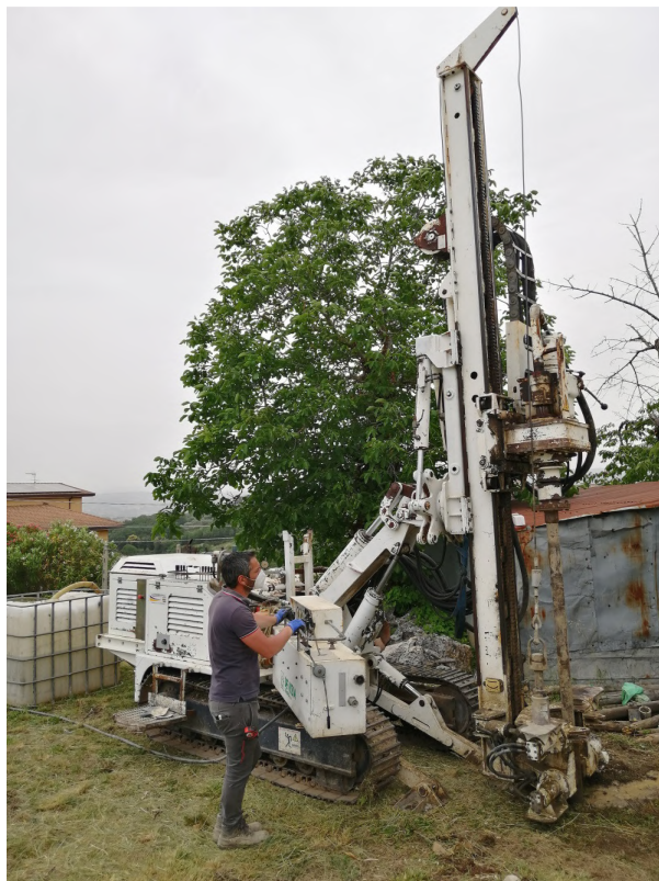
Postazione sondaggio S3
